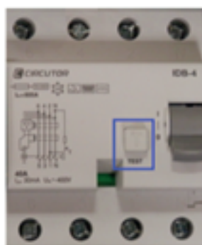
Figura 40: Botón Test del dispositivo de protección diferencial.
